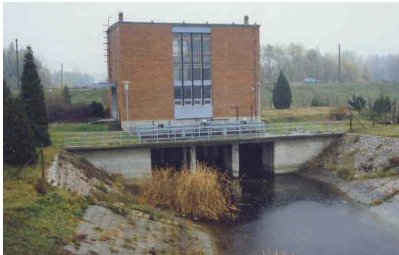
5. ábra. Szivattyú állomás
