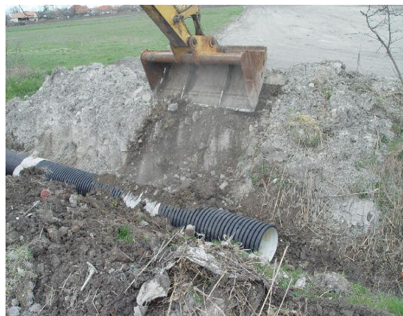
2. sz. fotó: Vízelvezetés helyreállítása Készítette: Bárdos Zoltán 2010.
