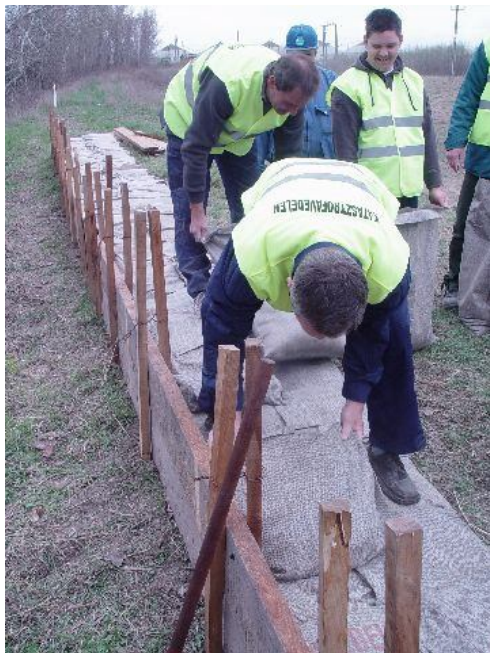
3. sz. fotó: Nyúlgát építése Készítette: Bárdos Zoltán 2010.
