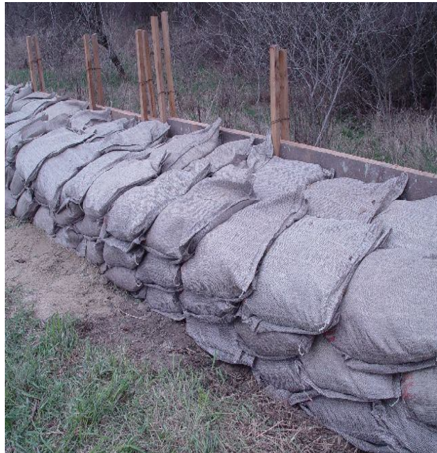
4. sz. fotó: Nyúlgát szádfallal Készítette: Bárdos Zoltán 2010.
