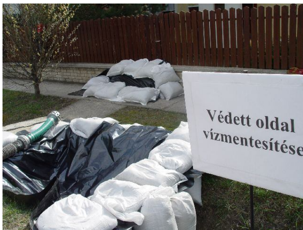
1. sz. fotó: Ingatlanok belvíz elleni bevédése Készítette: Bárdos Zoltán 2010.
