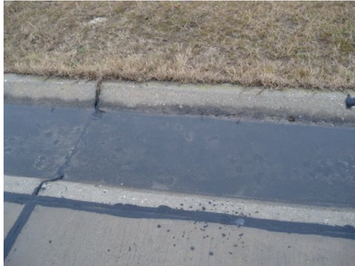
21. ábra. Vízyűjtő árok [fotó: Szabó Zsolt]
