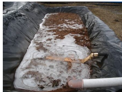
7. ábra: Iszapszikkasztó [fotó: Szabó Zsolt]
