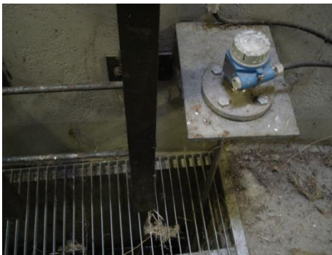
19. ábra. Üzemanyag koncentrációját figyelő szonda
