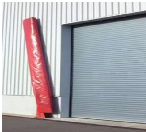
6. fénykép: Lengő mobil gát bejáratához és kettős gumitömlő mobil rendszer [11]
