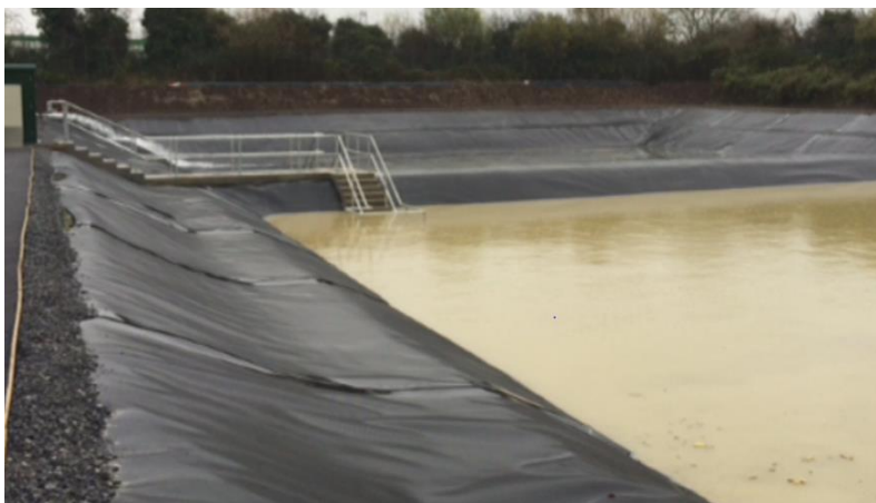
4. fénykép: Oltóvíz felfogó tároló létesítmény [11]
