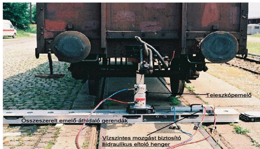
5. kép: Vasúti jármű emelése egy ponton [8]
