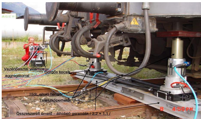
6. kép: Vasúti jármű emelése két ponton [8]
