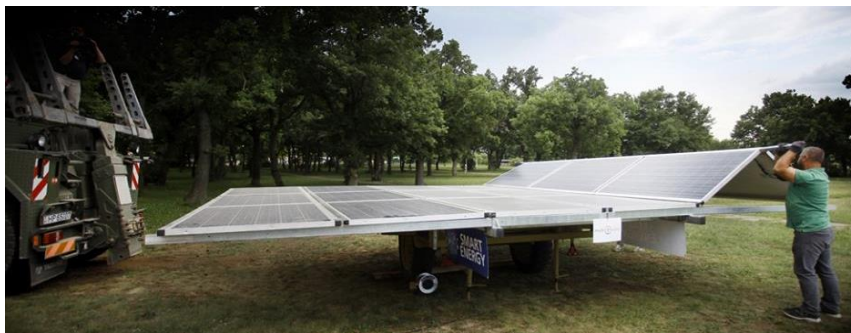
3. kép: Szolár-utánfutó telepítése a CL15 gyakorlaton.
