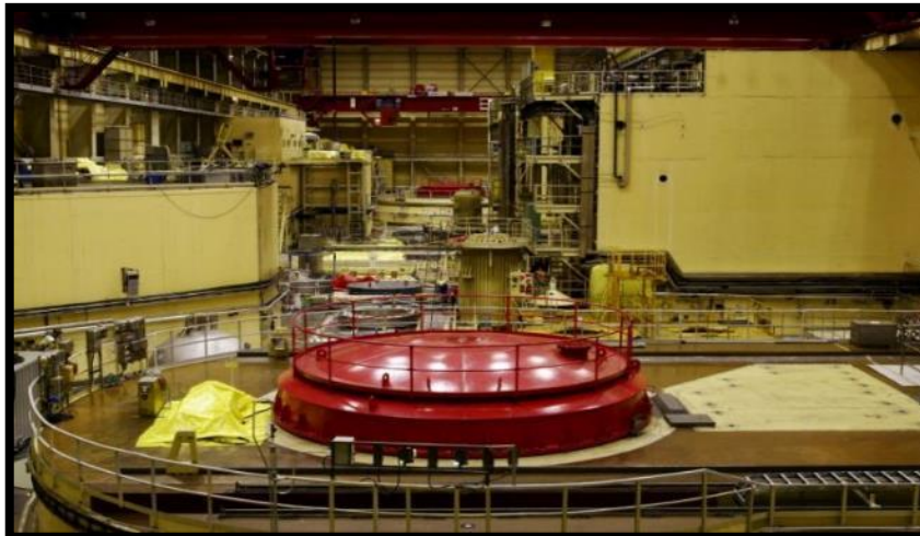
2. fénykép. Két reaktor egy csarnokban, a háttérben a kiégett üzemanyagot szállító konténerek. [4]
