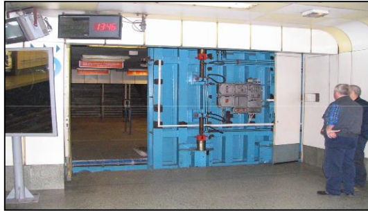
2. ábra. Csarnok elzáró kapu a 2-es metró állomásánál
