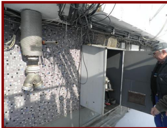
8. ábra. A tartályra csatlakozó 2 db B 95-ös nyomótömlő
