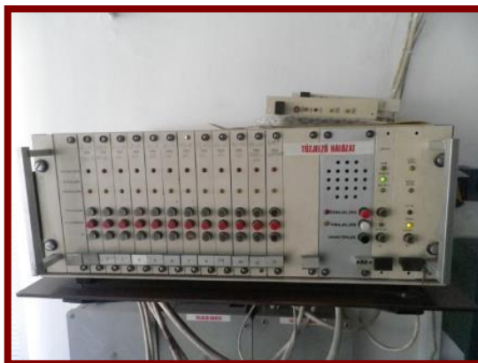
4. ábra. MGM típusú tűzjelző hálózat
