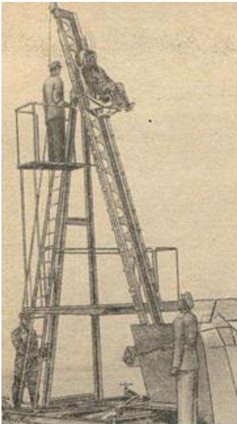
8. ábra. Az NKTL-3 típusú gyakorló katapult-berendezés.
