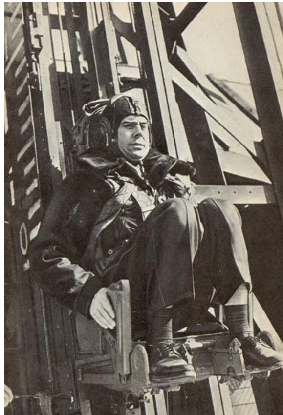
8. ábra. Az NKTL-3 típusú gyakorló katapult-berendezés.
